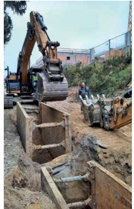
Bei der Bernaschekstraße wird ein Teilabschnitt der Straße sowie der Gehsteig erneuert und am Nelkenweg wird ein Trennsystem für Abwässer sowie eine neue Wasserleitung verlegt.
