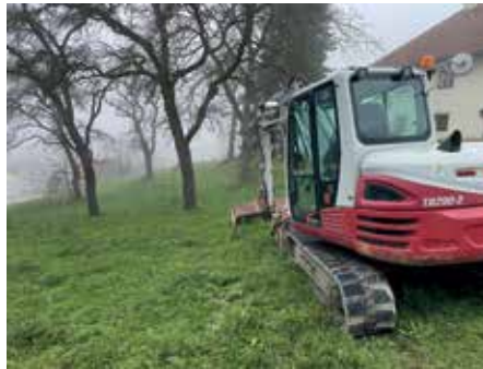
Oberhalb der Bernaschekstraße wurden Bodenuntersuchungen durchgeführt © Gemeinde Mauthausen
