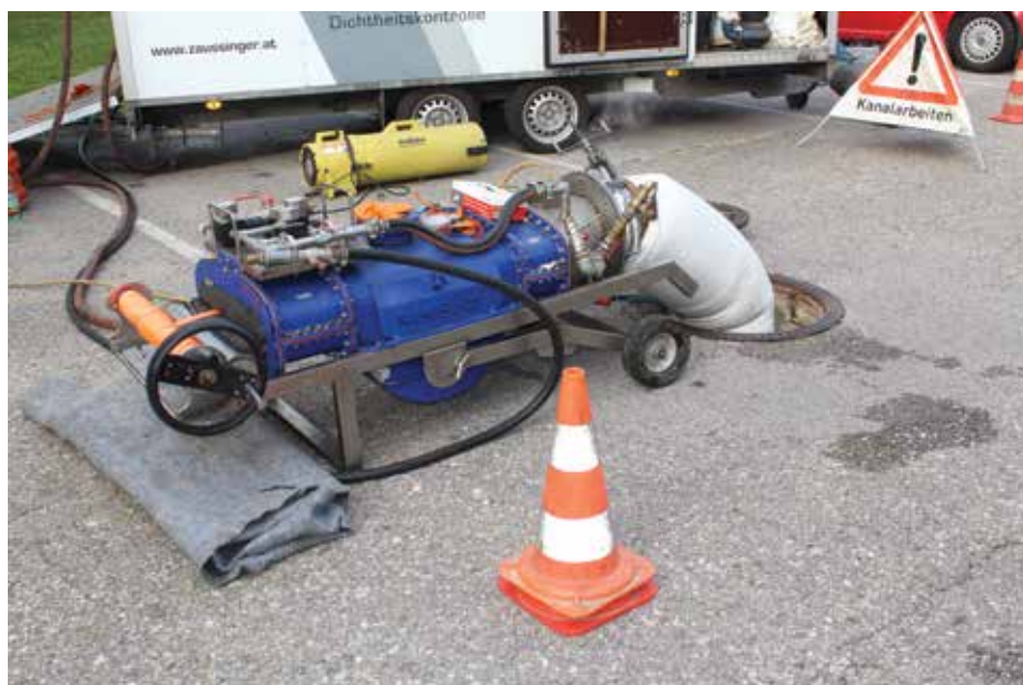
Kanal Inliner © Gemeinde
