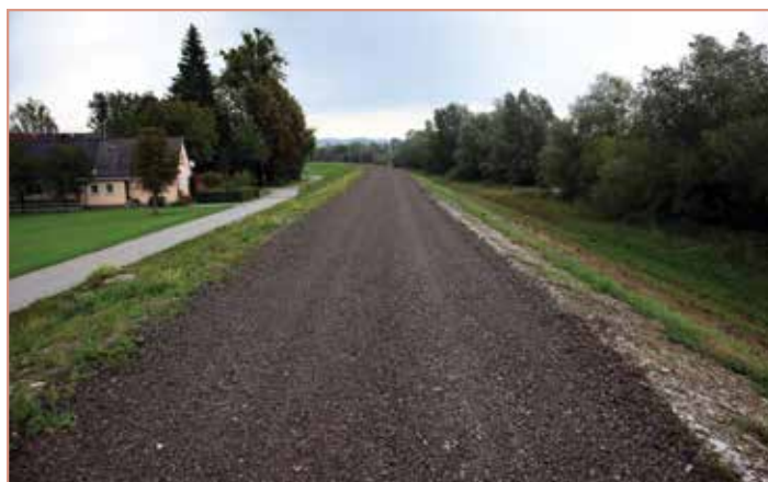
Der Aistdamm soll künftig vor Hochwasser schützen © Gemeinde
