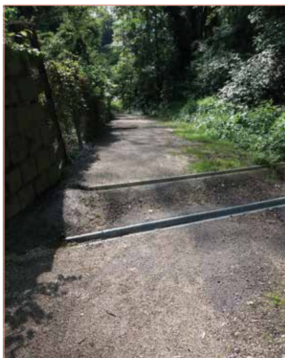
Entwässerungsmaßnahmen und die aufgebrachte Kiestragschicht © Gemeinde
