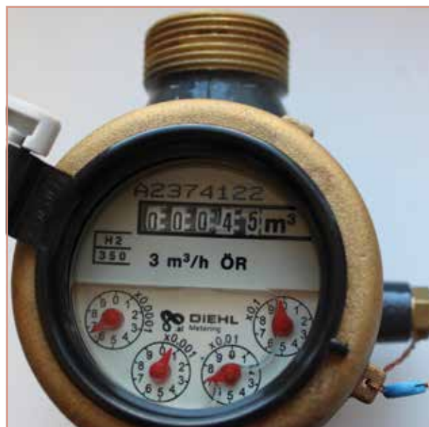
Sind alle Wasserentnahmestellen geschlossen, darf der Wasserzähler keinen Verbrauch anzeigen, dh. sämtliche roten Pfeile sowie die Zahlen müssen still stehen. Falls nicht, kontaktieren Sie umgehend den Wassermeister der Marktgemeinde Mauthausen. © Marktgemeinde Mauthausen
